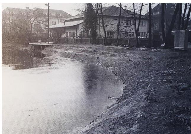
Abbildung 26: Wiederhergestellte Flachufer am Egelsee mit massiver Holzkonstruktion, Sanierung des Egelsees im Jahre 1996
