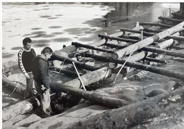
Abbildung 25: Massive Holzkonstruktion für die Sanierung des Egelsees im Jahre 1996
